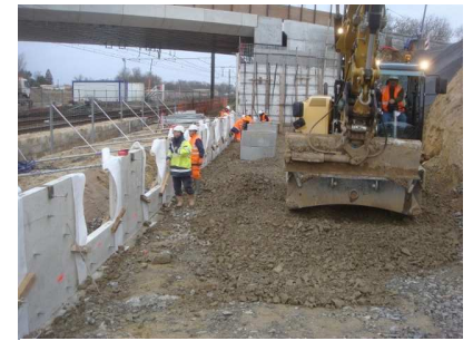
2ème phase du Pont R.Coty à Ambarès
